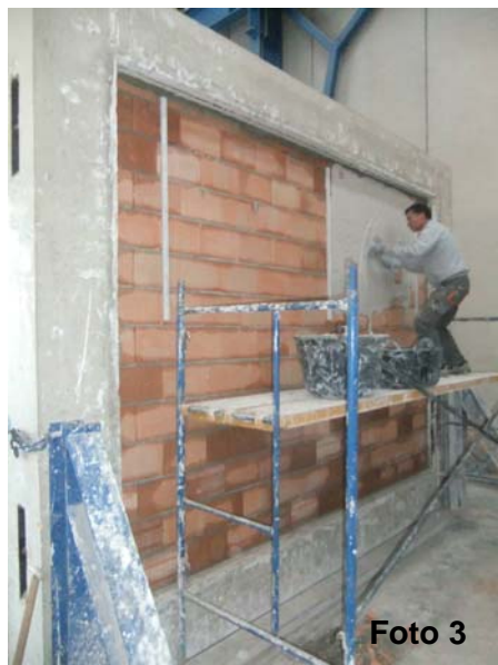
Fotos 3 y 4: Aplicación de revestimiento de yeso por ambas caras
