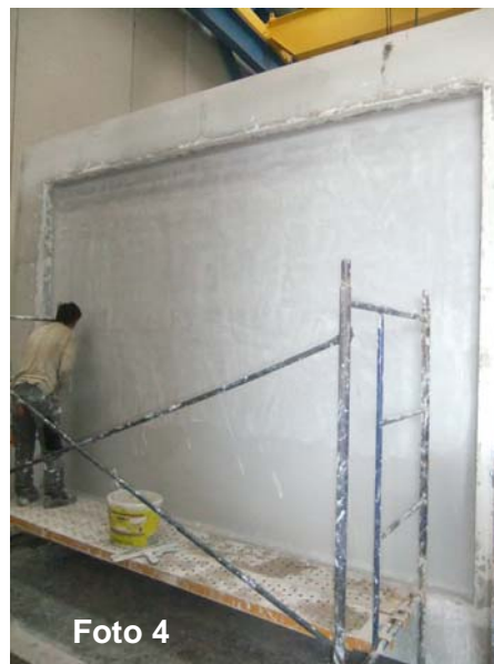
Fotos 3 y 4: Aplicación de revestimiento de yeso por ambas caras
